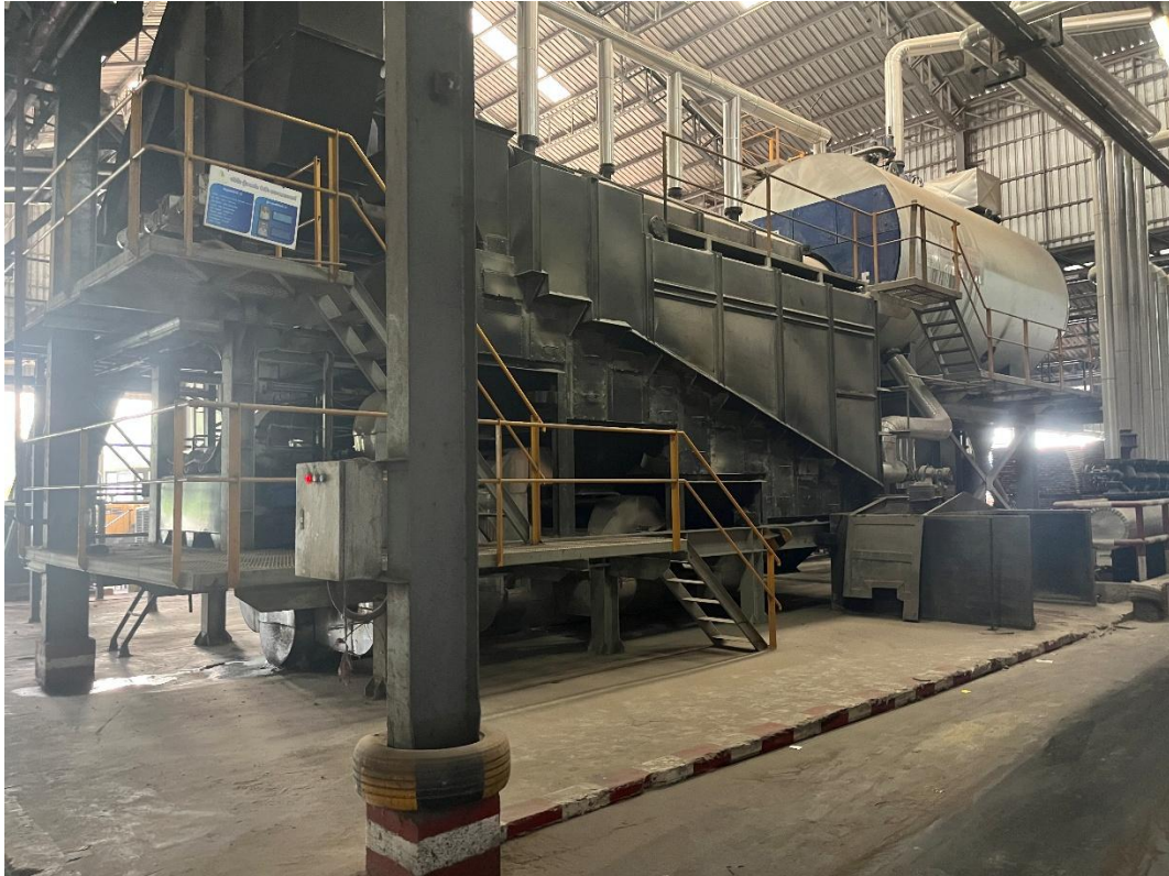
รูปที่ 01 หม้อน้ำขนาด 15 ตันต่อชั่วโมง ซึ่งมีการใช้ไม้สับ (wood chip) เป็นเชื้อเพลิง
