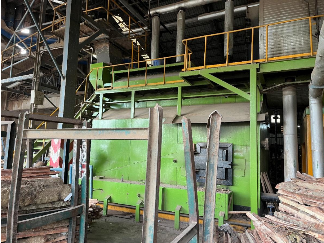
รูปที่ 02 หม้อน้ำขนาด 10 ตันต่อชั่วโมง ซึ่งมีการใช้ไม้พื้น และขี้เลื่อยเป็นเชื้อเพลิง
