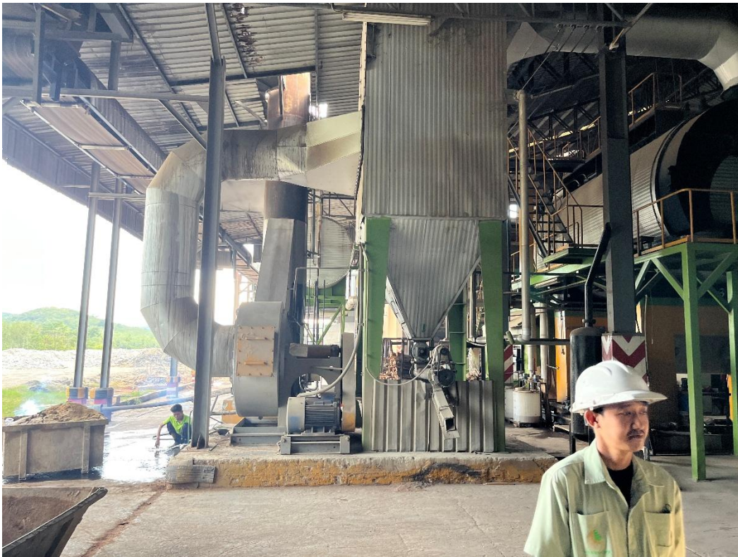
รูปที่ 04 ระบบจัดมลพิษทางอากาศแบบระบบไซโคลน (Cyclone) ที่ใช้สำหรับหม้อน้ำ 10 ตันต่อชั่วโมง
