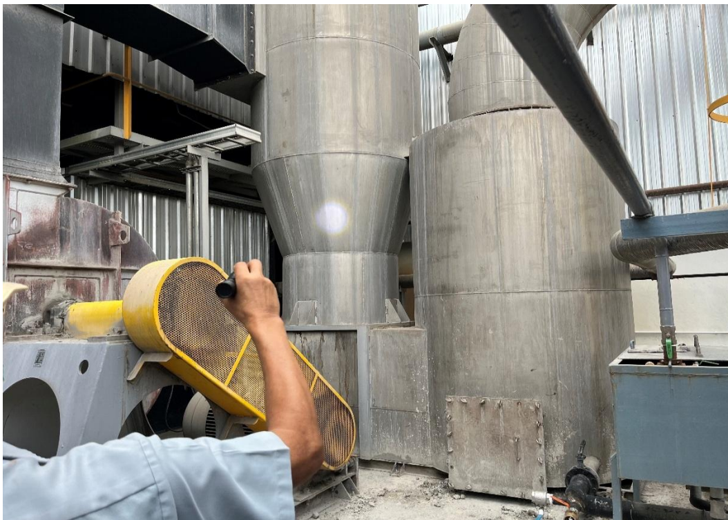
รูปที่ 05 ระบบจัดมลพิษทางอากาศแบบระบบมัลติไซโคลน (Multi-Cyclone) ต่ออนุกรมกับระบบจัดมลพิษทางอากาศแบบเปียก (Wet Scrubber) ที่ใช้สำหรับหม้อน้ำ 15 ตันต่อชั่วโมง
